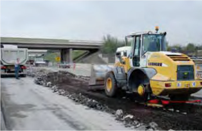
Reifenschaden auf der Baustelle
